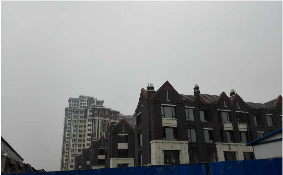
正荣.天津锦曦花苑项目消防工程
