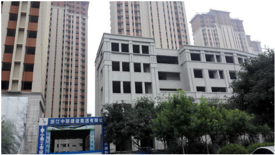
正荣·天津锦曦花苑项目消防工程
