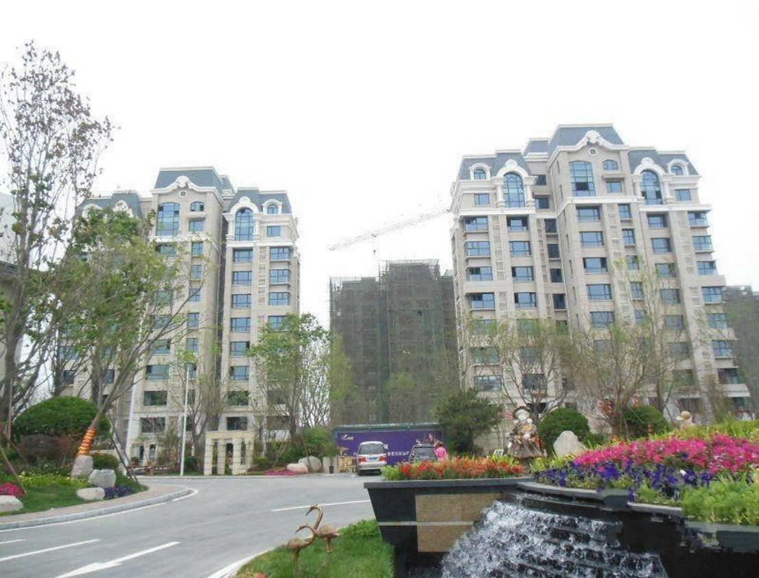
天津碧桂园滨海一标段至三标段消防水电及室外消防工程
