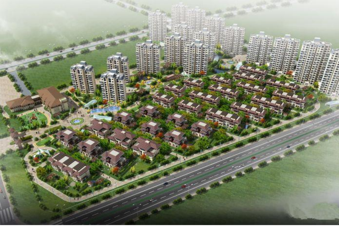
天津碧桂园滨海一标段至三标段消防水电及室外消防工程
